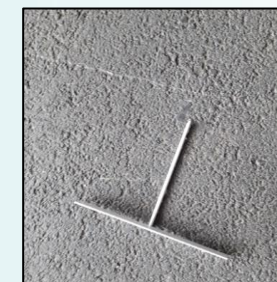
Réemploi d'éléments métalliques
